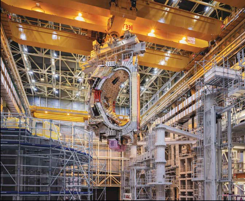
20 Baustelle der Superlative: Modul des ITER-Fusionsreaktors in der Montagehalle.
